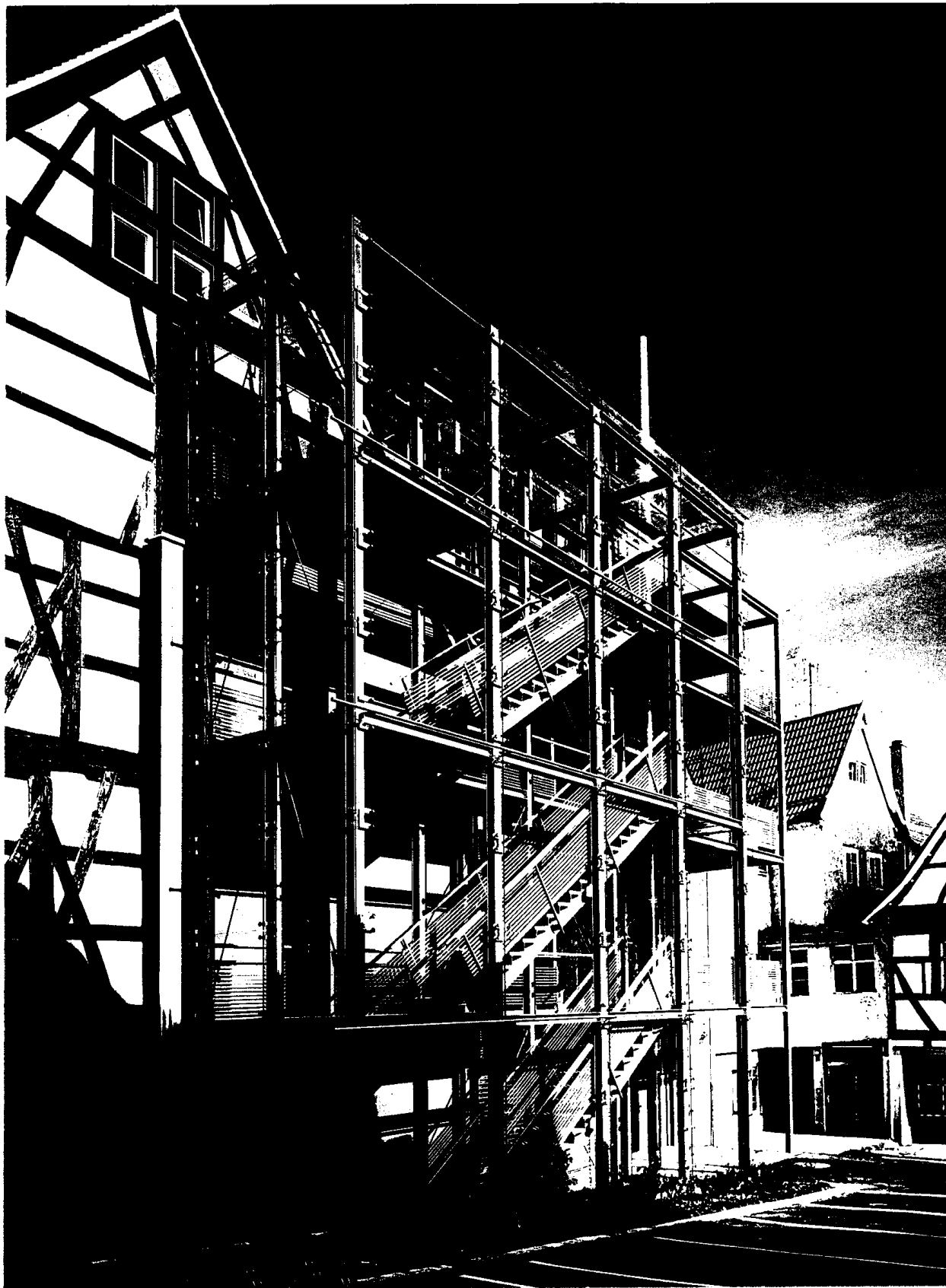
Bild 1 Vollverglaster Anbau eines Treppenhauses
