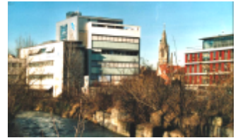
Obere Wassere 4, 1995-97 Obere Wassere 1, 1998-99
